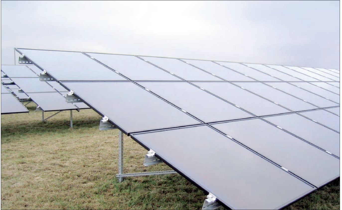
Модули тонкоплёночные, в раме, трёхрядные, вертикальные
