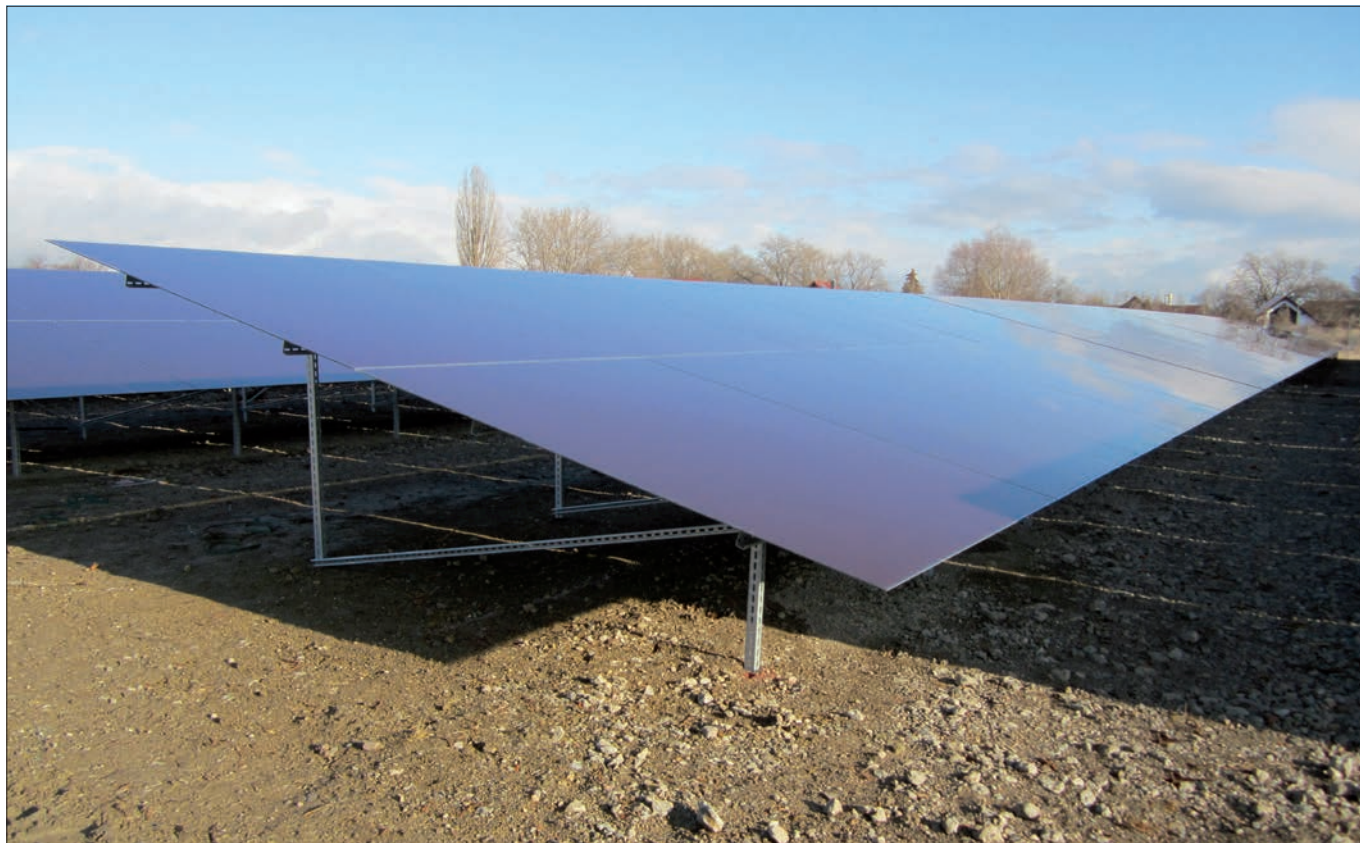
Модули тонкоплёночные с рамными рельсами, 2,6 x 2,2 м, двухрядные, вертикальные
