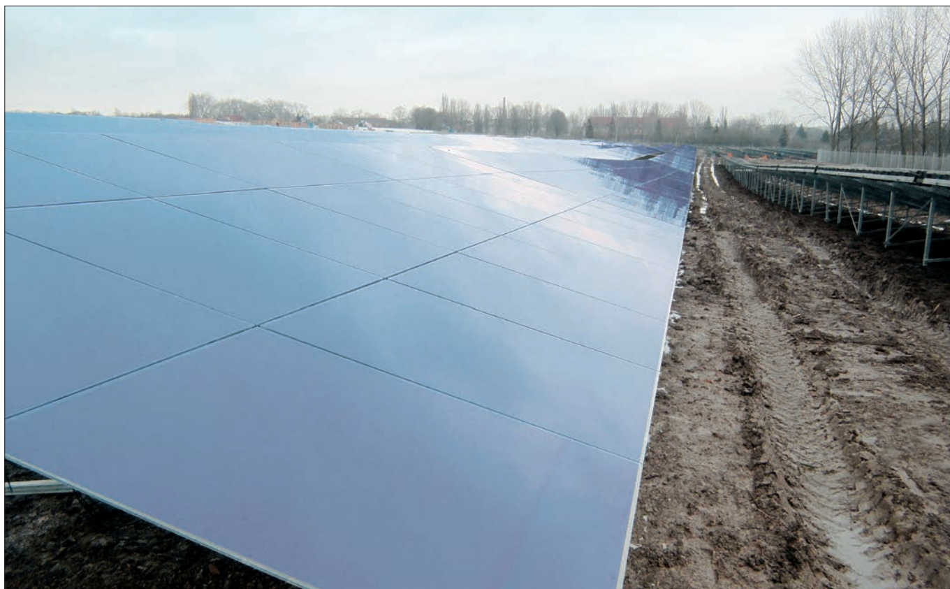
Модули тонкоплёночные с рамными рельсами, 1,3 x 1,1 м, трёхрядные, вертикальные
