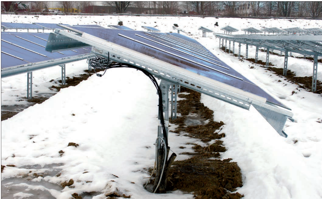
Модули тонкоплёночные 1,3 x 1,1 м, однорядные, вертикальные
