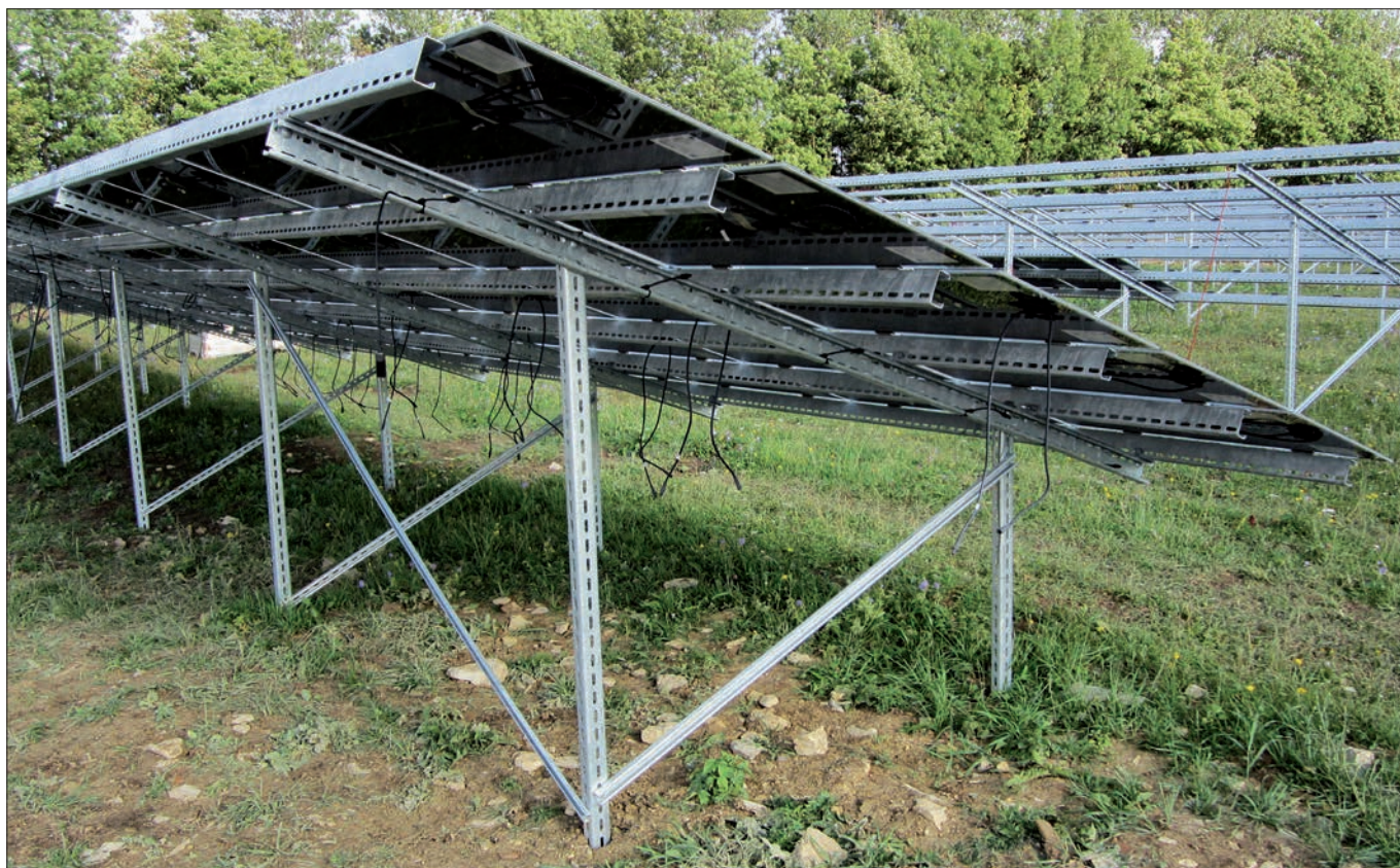
Модули тонкоплёночные, пятирядные, горизонтальные
