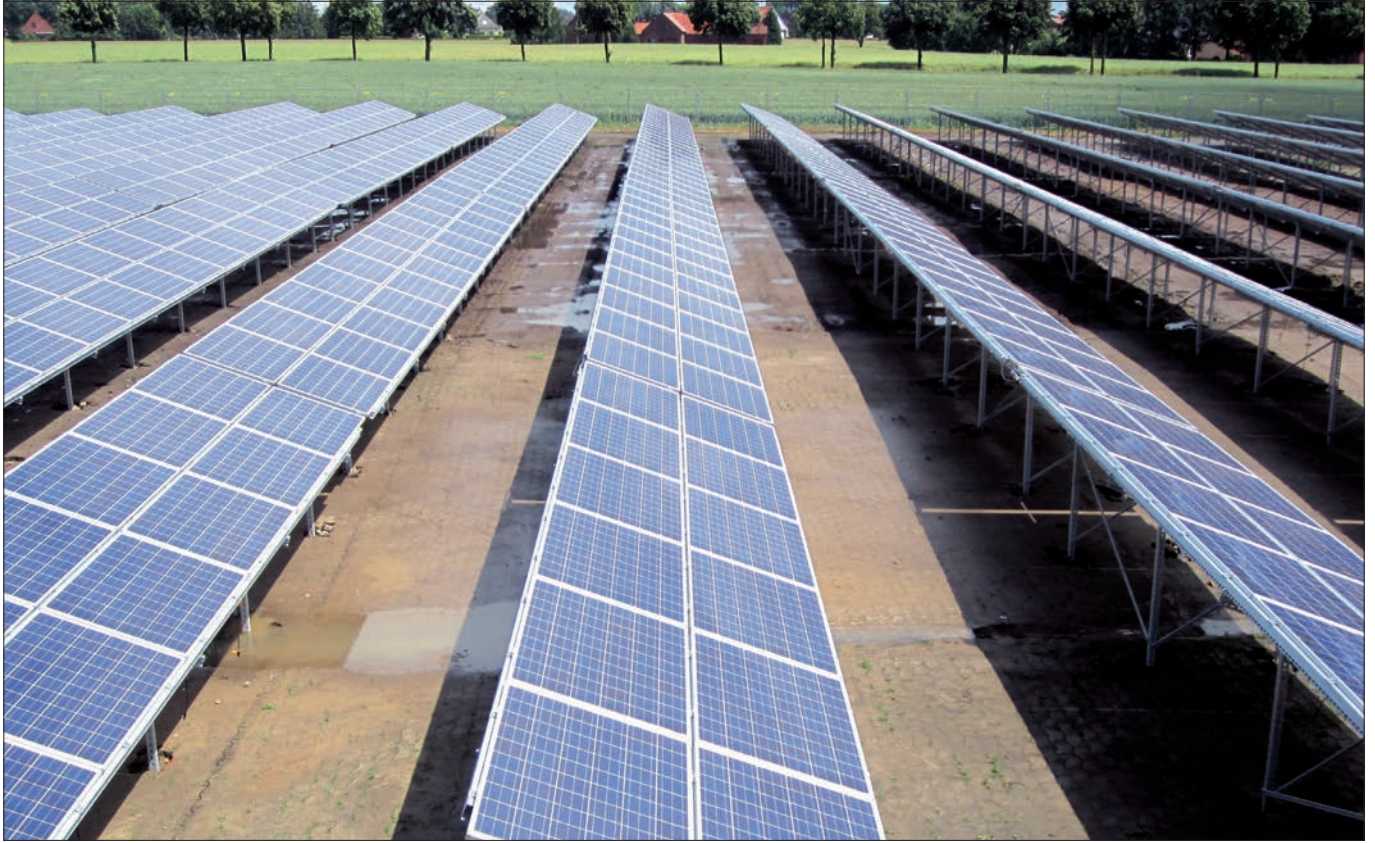
Модули кристаллические, двухрядные, горизонтальные
