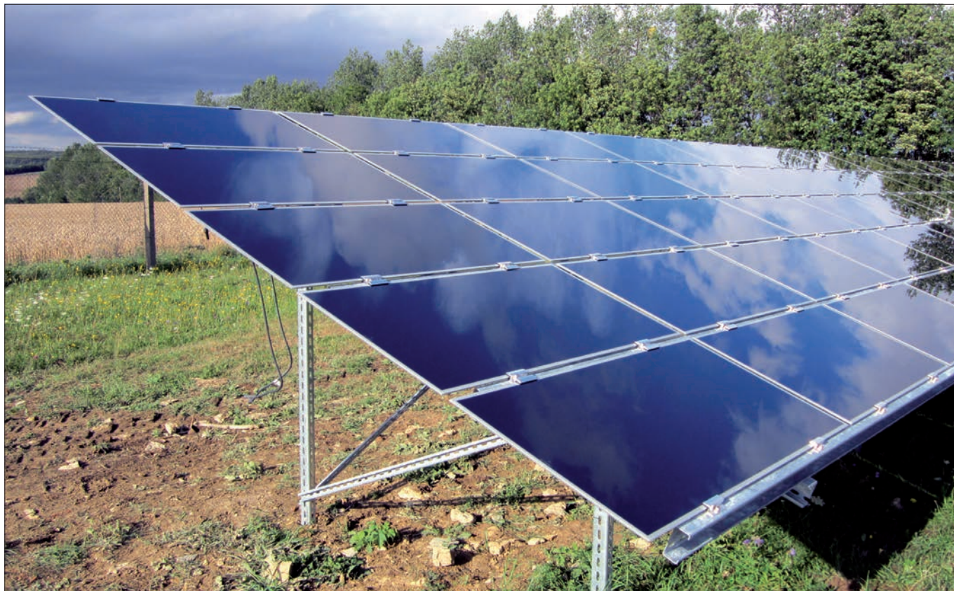
Модули тонкоплёночные, пятирядные, горизонтальные
