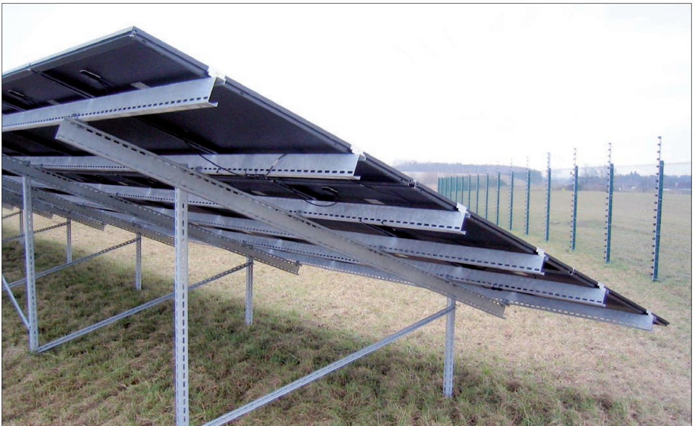
Модули тонкоплёночные, в раме, трёхрядные, вертикальные
