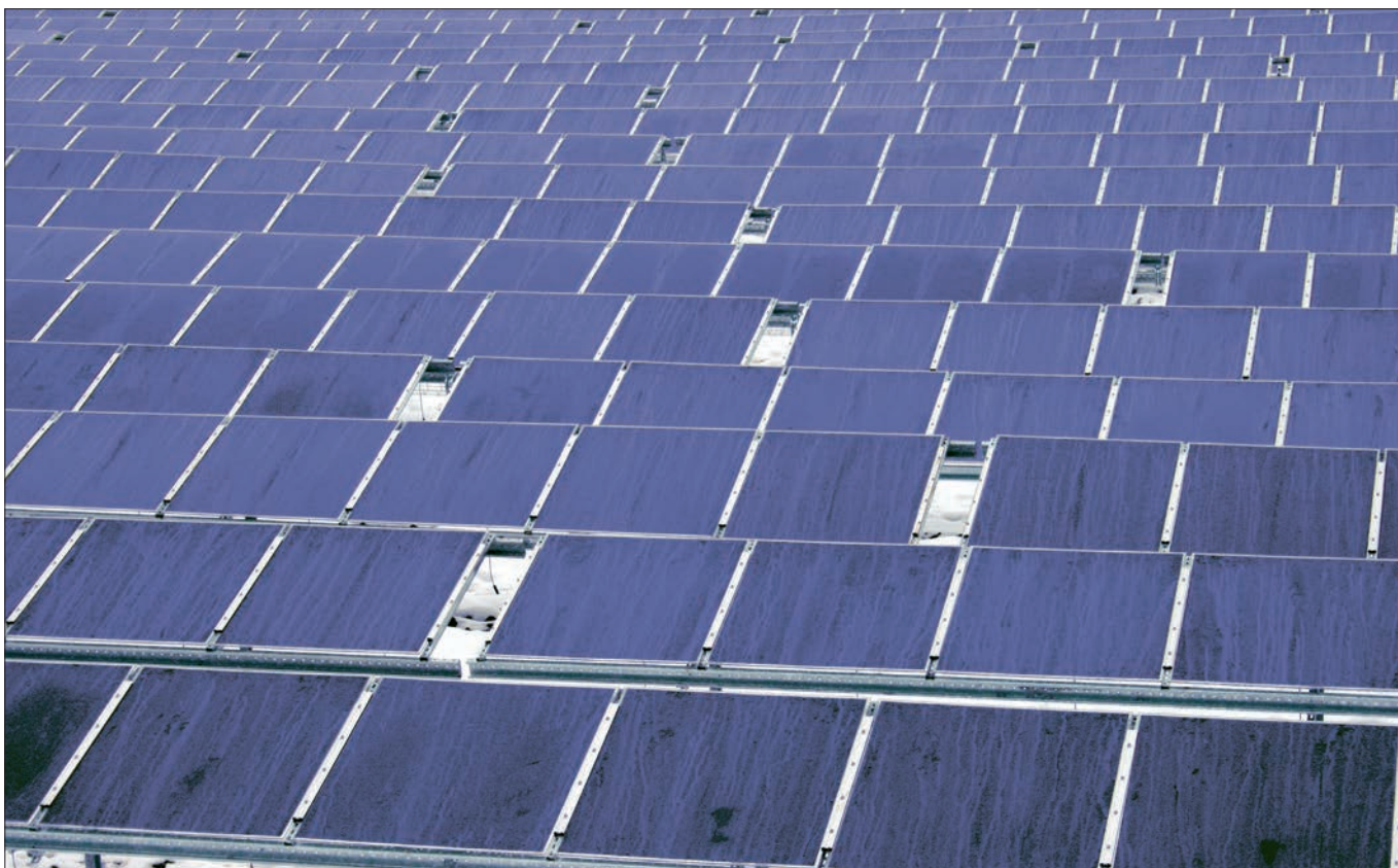
Модули тонкоплёночные 1,3 x 1,1 м, однорядные, вертикальные
