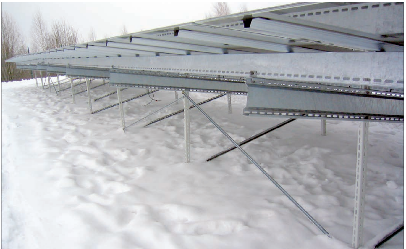
Модули тонкоплёночные с рамными рельсами, 2,6 x 1,1 м, двухрядные, вертикальные
