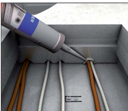
Все получившиеся отверстия должны быть обработаны силиконом или огнеупорной пеной.
